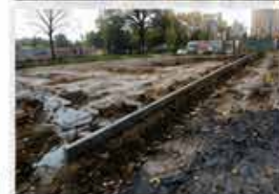
2 Erste Kantensteine gesetzt
