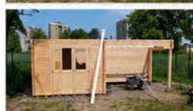
2 Hütte fast fertig
