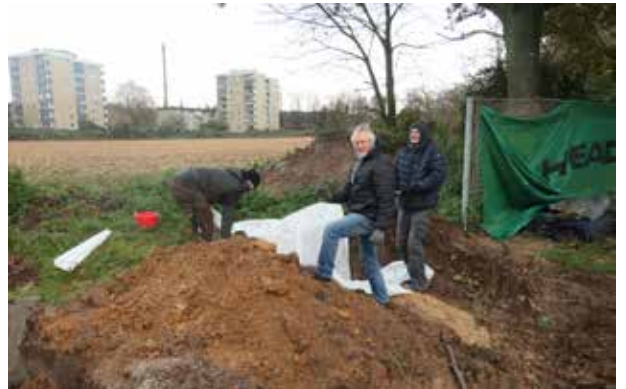
Das Oberflächenwasser des versiegelten Tennisplatzes erfolgt über das Quergefälle mit 0,5 % in eine Mulde von 2,50 m Breite und 3,00 m Tiefe parallel zur Längsseite des Tennisplatzes.
