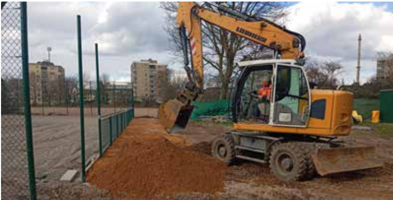
Baggerarbeiten durch die Firma Tiefbau Trimborn zur Vorbereitung der notwendigen Bepflanzung der Mulde.
