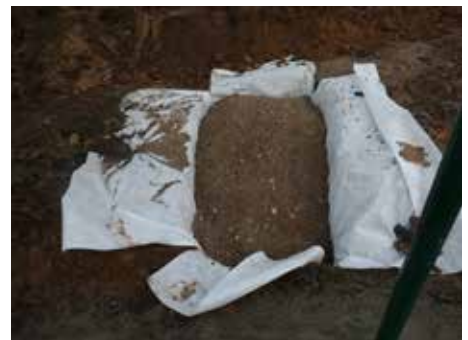
Die Weiterleitung des Oberflächenwassers über die Mulde bis ins Grundwasser wird durch unterhalb der Mulde angeordnete Sickerfenster bis in die wasserführende Schicht gewährleistet.
