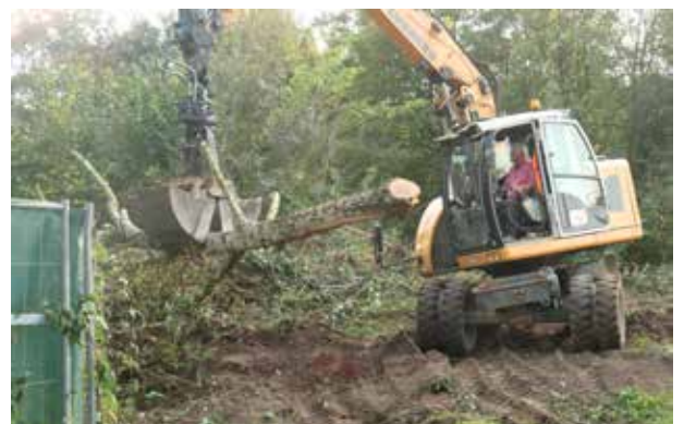
Baggerarbeiten zur Auffahrt zu den Plätzen 1-4 durch Andreas von Tiefbau Trimborn.
