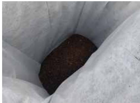
Die Weiterleitung des Oberflächenwassers über die Mulde bis ins Grundwasser wird durch unterhalb der Mulde angeordnete Sickerfenster bis in die wasserführende Schicht gewährleistet.
