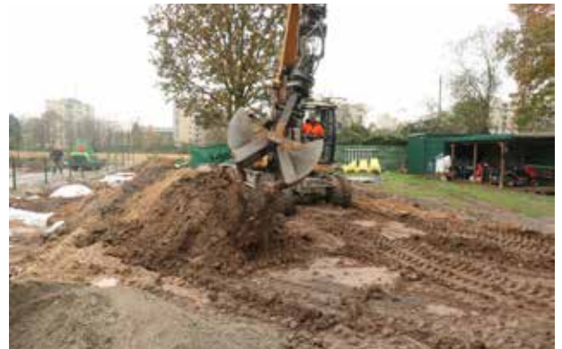
Der Bagger ist voll im Einsatz.
