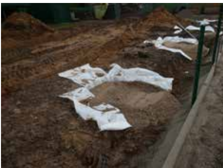
Die Weiterleitung des Oberflächenwassers über die Mulde bis ins Grundwasser wird durch unterhalb der Mulde angeordnete Sickerfenster bis in die wasserführende Schicht gewährleistet.
